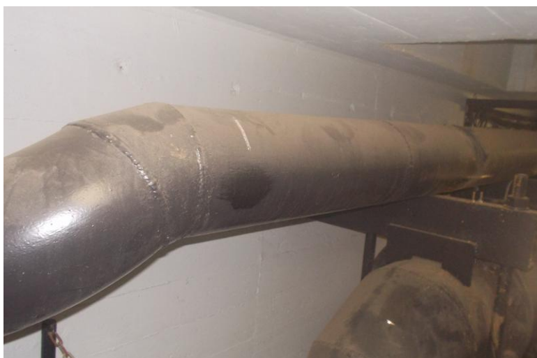
Umístění nového šoupěte DN200 na potrubí přímého plnění
